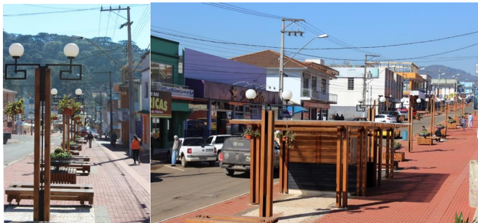
Figura 11 - Revitalização da avenida Dr. Oscar Geyer em 2012
